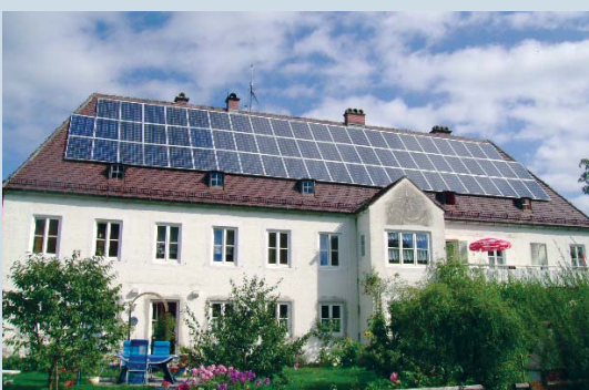
Sorgen für Umweltentlastung: Photovoltaik-Anlagen auf städtischen Dachflächen, wie beispielsweise in der Weidachstraße.
