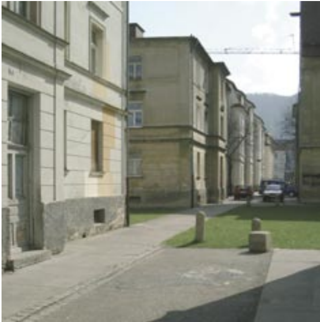
Blick vom nördlichen Wohnhof der Hanfwerke-Siedlung (Block VI) nach Süden, April 2007
