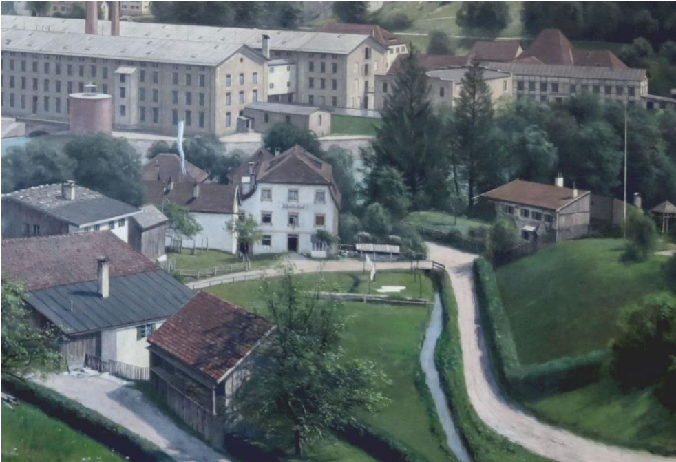
Abb. 26: August Splitgerber, Mechanische Seilerwarenfabrik & Faulenbach 1905 (Ausschnitt).
