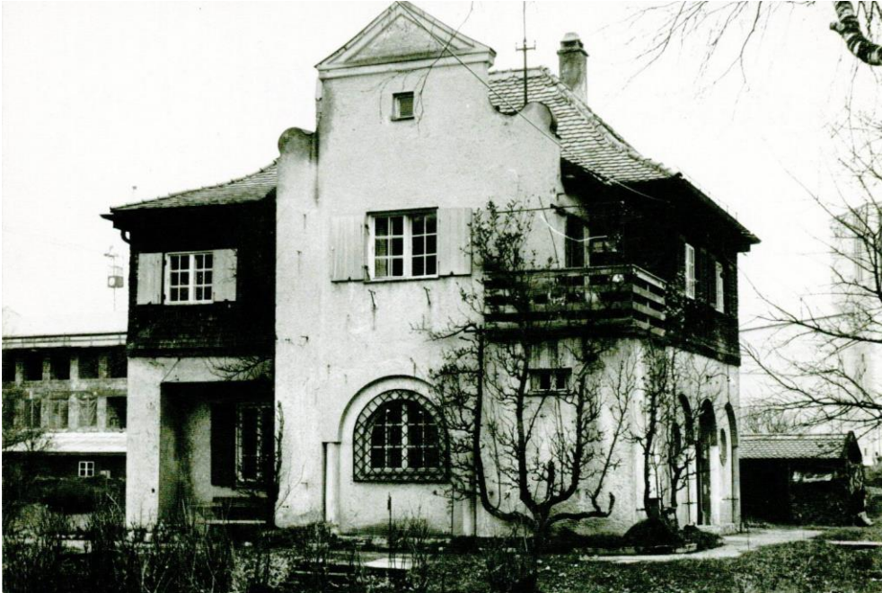
Abb. 6: Das Wasserwerk vor dem Abriss im Jahr 1965. Im Hintergrund ist die Mittelschule schon im Bau; StdAF, BZ 4-528.
