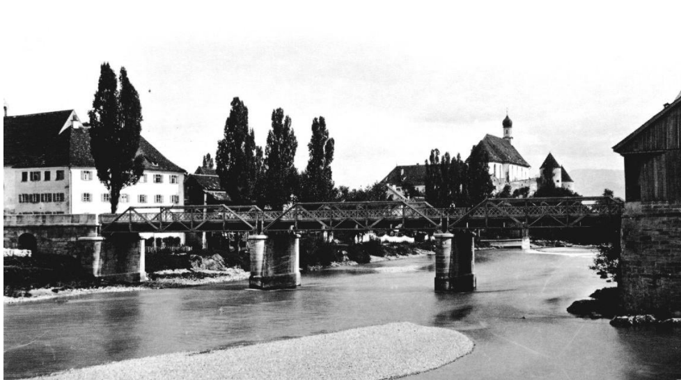
Abb. 2: Die neu erbaute eiserne Theresienbrücke 1877; StdAF, BS 684.
