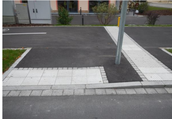
Abb. 55: Fachgerecht angelegte Bodenindikatoren in der Augsburger Straße in Füssen
