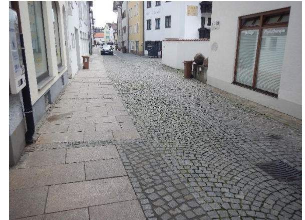
Abb. 38: Mittig verlaufende Abflussrinne mit Seitengefälle
