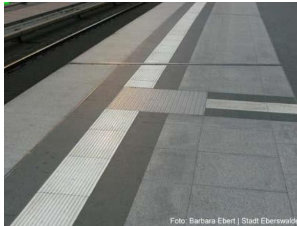
Abb. 56: Fachgerecht angelegtes Blindenleitsystem in Eberswalde
