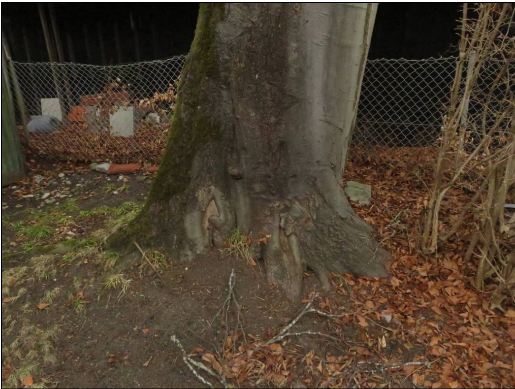
Schäden Wurzelanläufe südseitig
