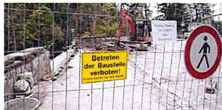
Die Bauarbeiten für die Aussichtsplattform am Lechfall in Füssen haben begonnen und sollen bis Mitte November abgeschlossen sein. Foto: Michael Lukaszewski
